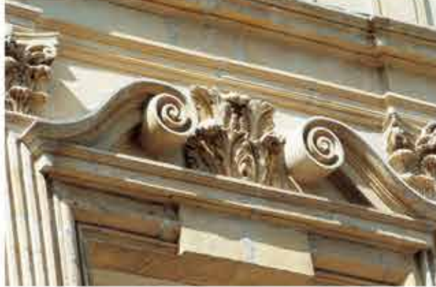
Fronton curviligne, détail de façade, 29 place Saint-Pierre
