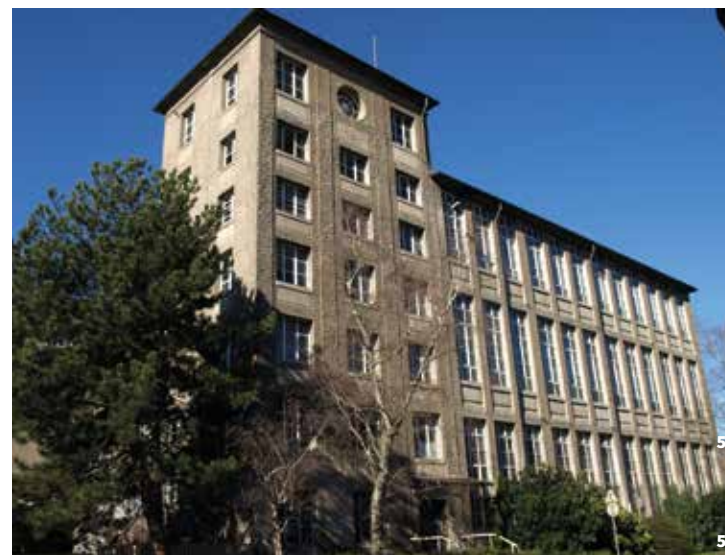
5. Bâtiment du « Louvre » Schlumberger à Guebwiller, Photo Pah - CCRG.
